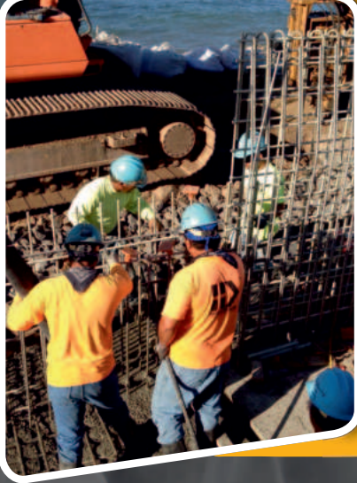
Barrier Walls Bariyer Duvarları
